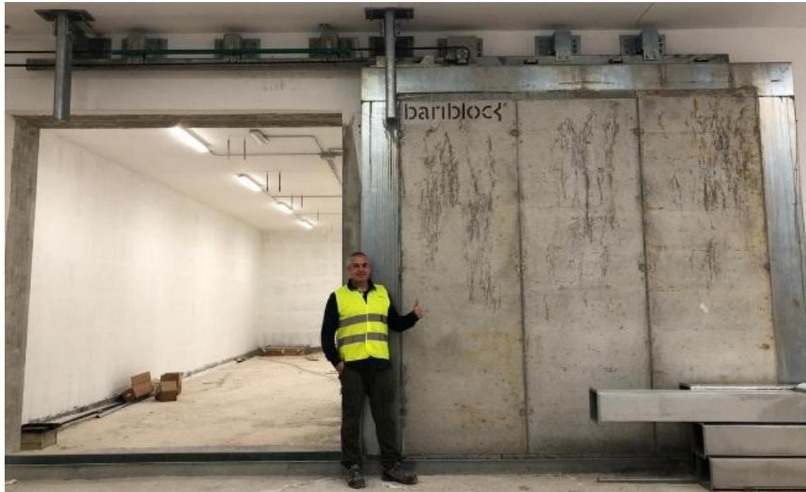
**SVA S.r.l** fornisce prefabbricati in calcestruzzo baritico per bunker per controlli non distruttivi. In foto è mostrato un [portone in calcestruzzo baritico](#) con sistema di movimentazione elettromeccanico integrato realizzato per **Metalprove S.r.l.**
